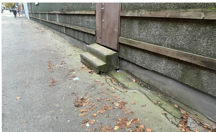
Figur 15. Sättning vid Hultmans gränd, källa: Bohusgeo, 2022
