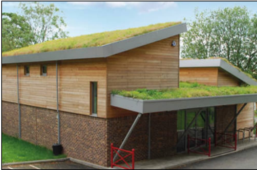
Bild ovan: Sedumtak kan anläggas både på platta och lutande tak (Svenska Naturtak AB, 2018).
