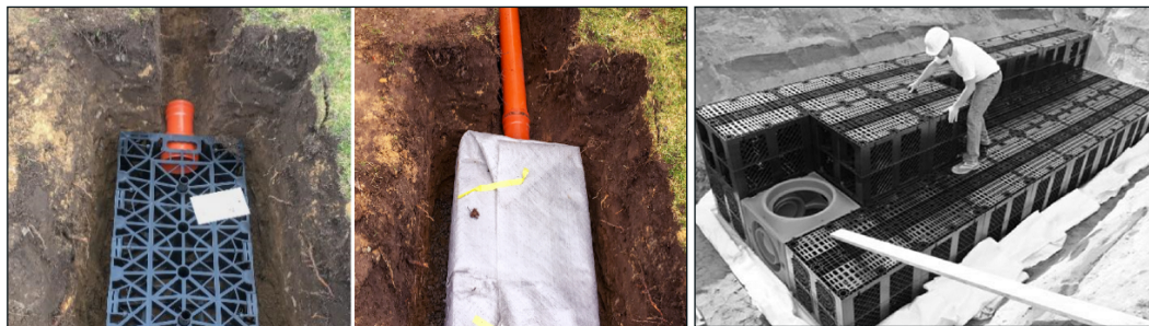
Figur 12. Till vänster, enkel dagvattenkassett som klätts in i geotextil och ansluten till takavvattning. Till höger, dagvattenkassetter sammankopplade till ett större magasin.
